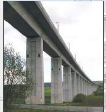
DB Trasse (Brückenbau)
